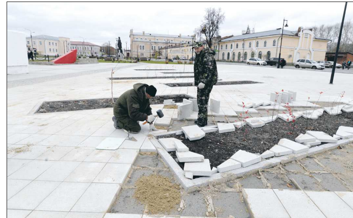
Подрядчики завершают укладку плитки на площади Ленина
