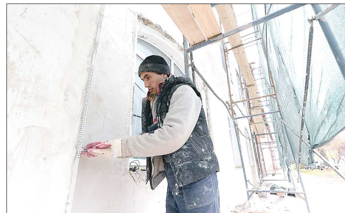
Дома «оделись» в строительные леса. На реставрацию одного дома, в среднем, уходит по 30 млн рублей
