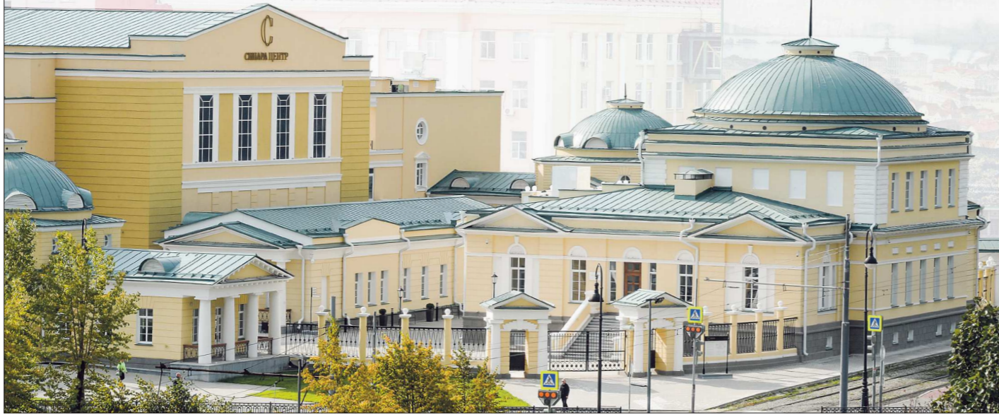
Здание бывшего госпиталя Верх-Исетского завода, построенного в 1824 году. Яркий пример привлечения частных средств для восстановления объекта культурного наследия. До реставрации бывший госпиталь считался одним из самых запущенных ОКН города. Открытие состоялось в 2019 году
