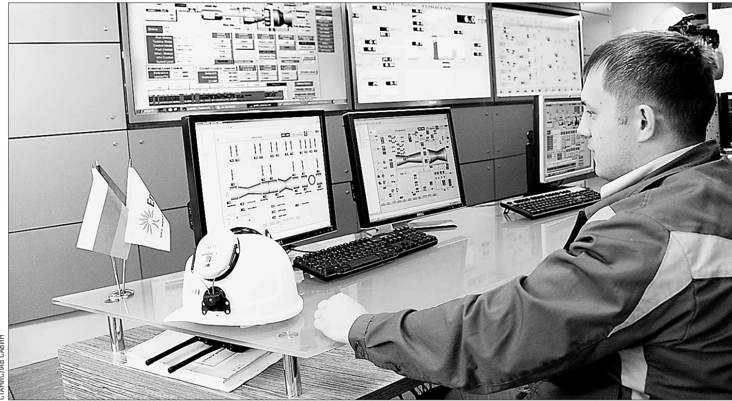
Мощность СУГРЭС выросла на 400 мегаватт
