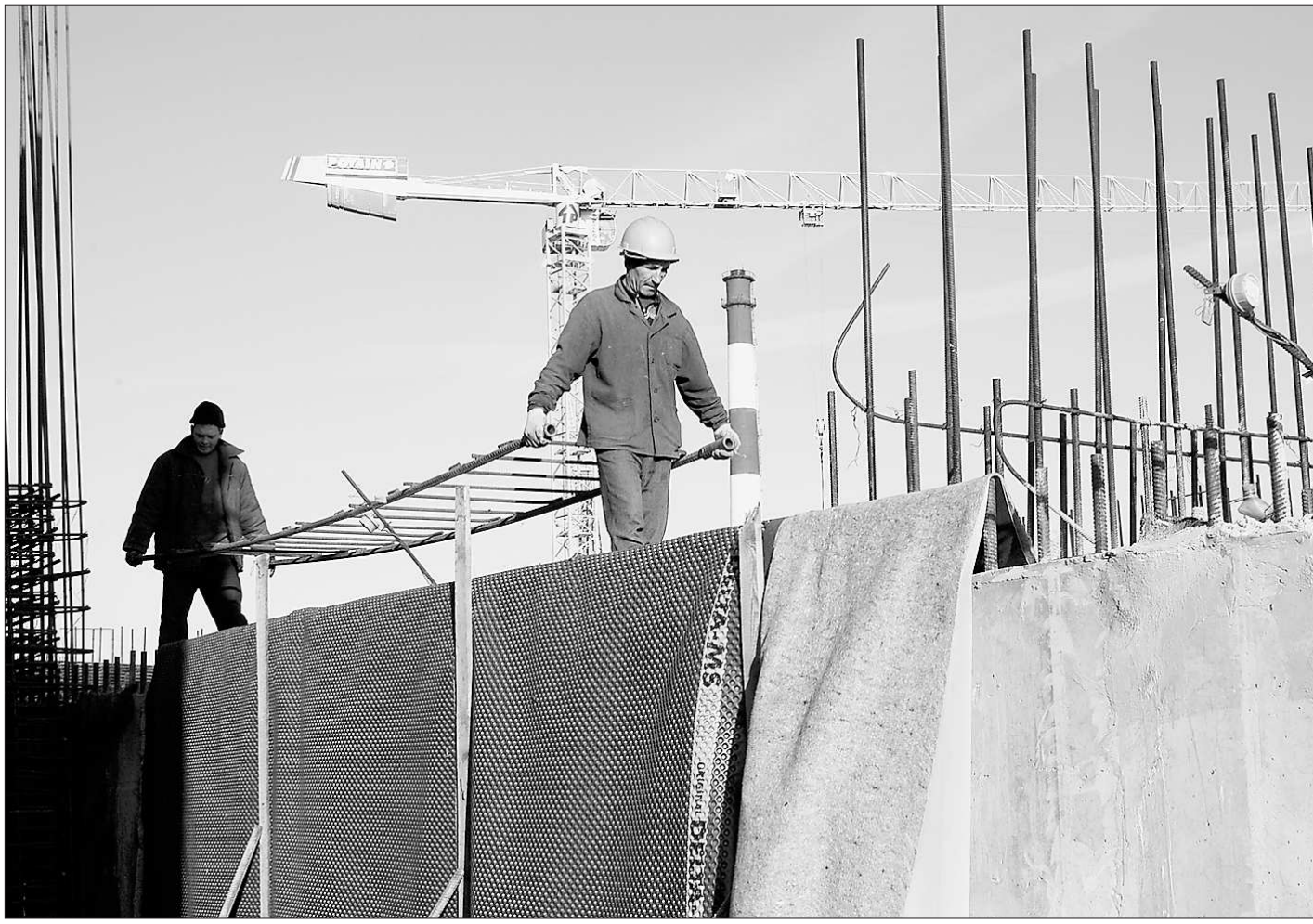
Все амбициозные проекты начинаются с обычной стройплощадки
