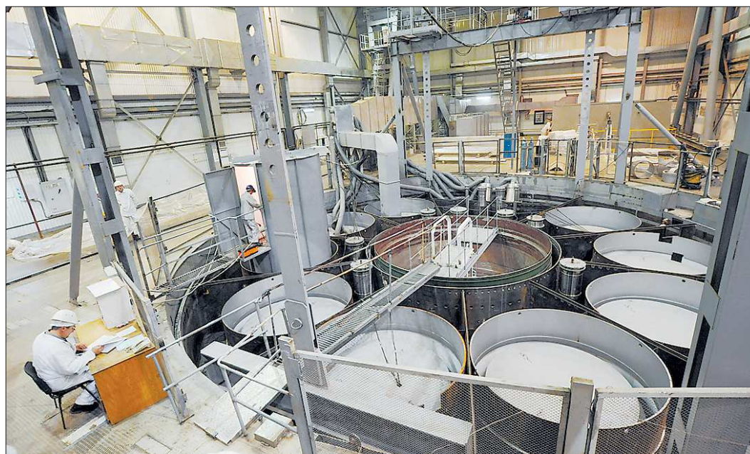
Идёт сооружение атомного реактора. Он будет работать в режиме замкнутого ядерно-топливного цикла, что позволит минимизировать образование радиоактивных отходов
