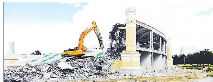
Работы по демонтажу арены уже идут, а завершить реконструкцию планируют в декабре 2017 года
