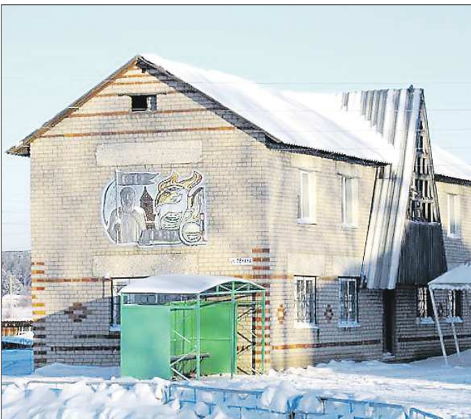
На время ремонта невянянский ФАП переехал в чужое здание, но жители уверены, что именно оно станет постоянным местом жительства для медпункта
