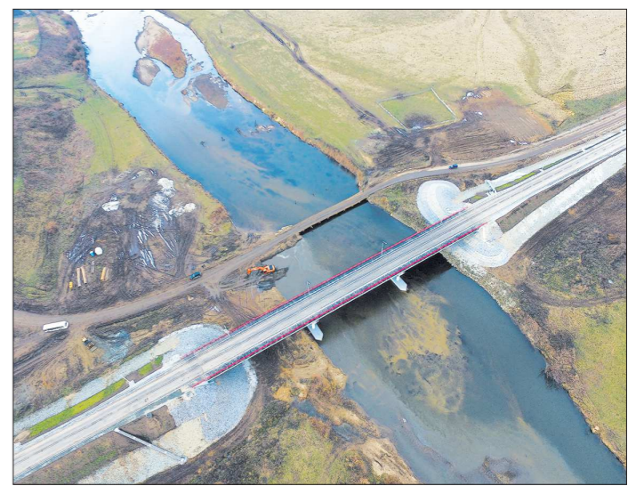
Первые сваи нового моста в селе Невьянское были вбиты 4 июня 2014 года
