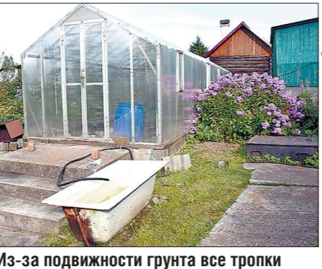
Из-за подвижности грунта все тропки в саду и подходы к теплице пришлось бетонировать
