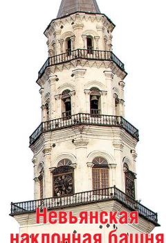
Невьянская наклонная башня
