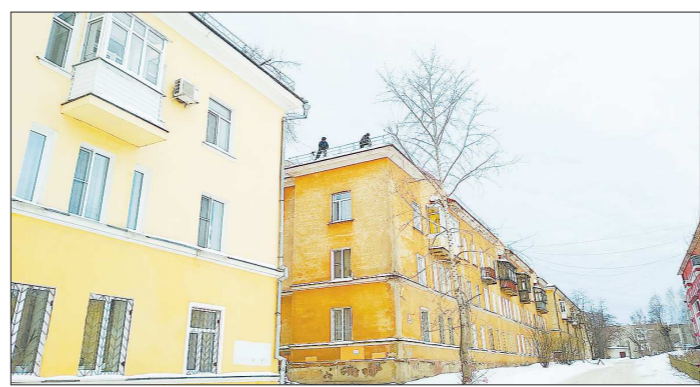
Капремонт идёт круглый год: сейчас строители занимаются кровлями. Справа — вид «до», слева — вид «после»
