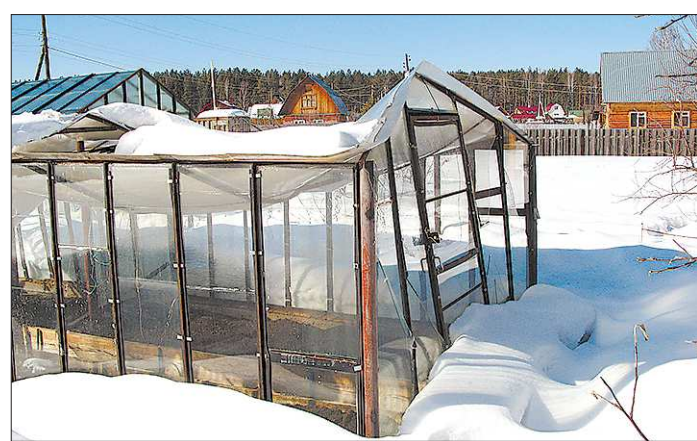
Результат разрушения теплиц от снеговой нагрузки бывает плачевным
