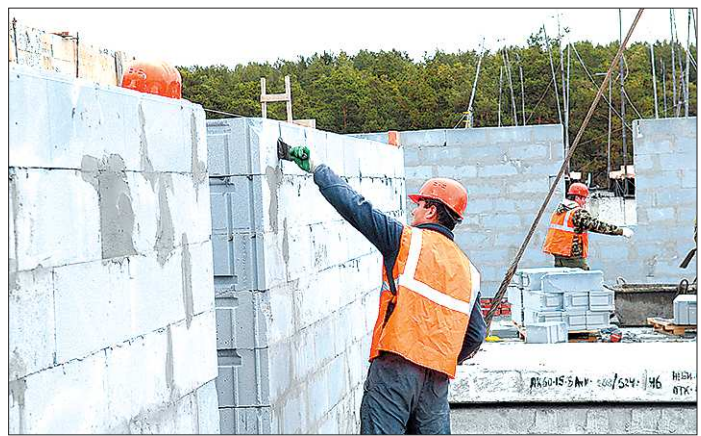
В 2019 году в Свердловской области усилят контроль за строительством жилья и соцобъектов
